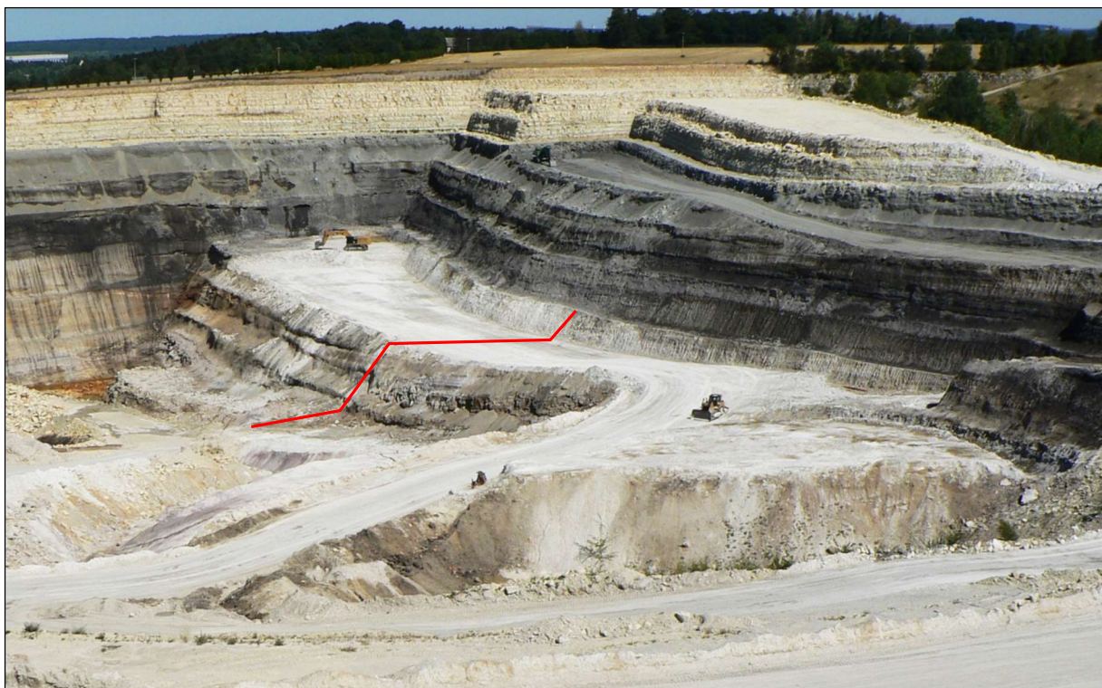
Pohled od Z k V z temene vnitřní deponie skrývkových hornin na aktivní část lomu: vlevo východní stěna, uprostřed a vpravo těžební postup k J v jižní stěně. Komplettní profil ve skrývkových řezech, vlevo dole neaktivní těžební a výklizové řezy. Přibližná stopa tektonického zlomu v karbonu je naznačena červenou čarou (srpen 2022).
